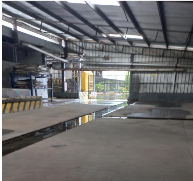
Ilustración. Cárcamo perimetral al interior de la bodega.
