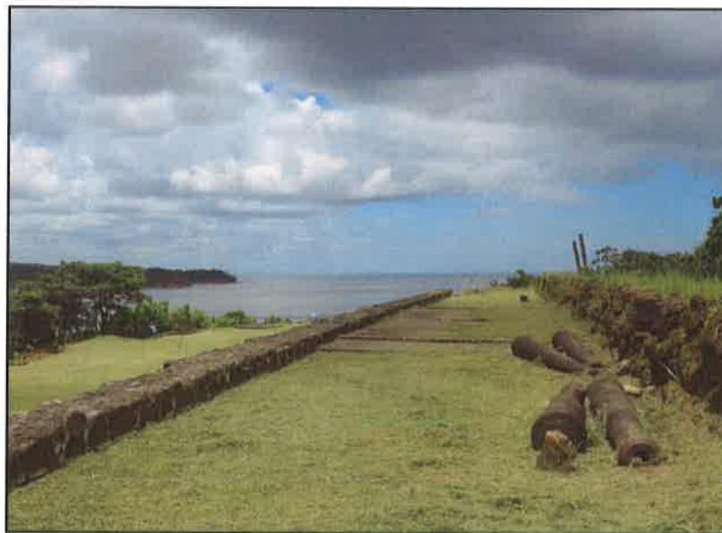
Ilustración 3. Área de Muro de Través y Plataforma Alta.
