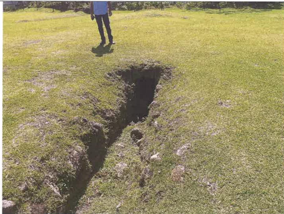
Foto 7. Salida del drenaje pluvial existente ubicado en la parte central del patio de armas.
