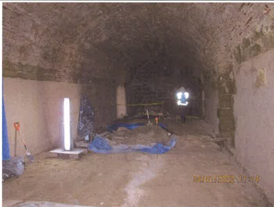
Foto 10. Bóveda principal donde se instalará el museo
