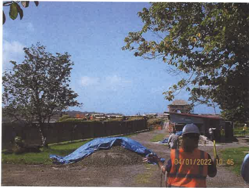
Foto 2. Vista del campamento y al fondo se observa las obras que están realizando al Castillo.
