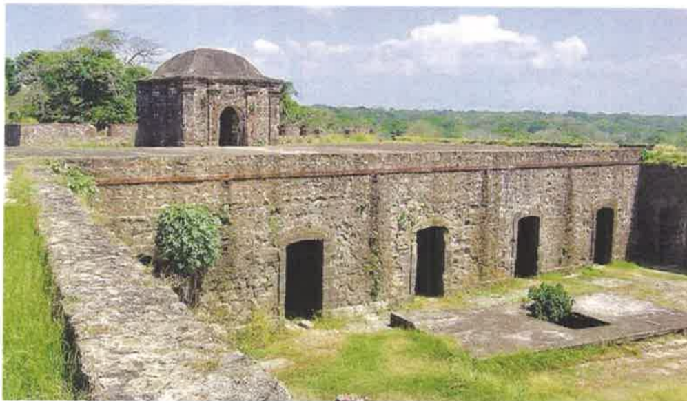
Foto 1. Estructuras del Castillo de San Lorenzo que serán restauradas.
