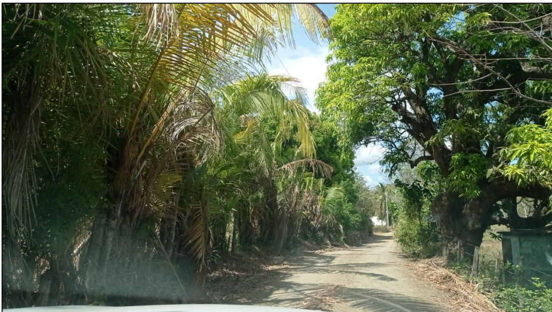
Fotografía N°4. Vista General de la vía a Rehabilitar – calle Río Arriba. Se observa Cerca de púa que se ubica del lado izquierdo, la misma se hará reubicación.
