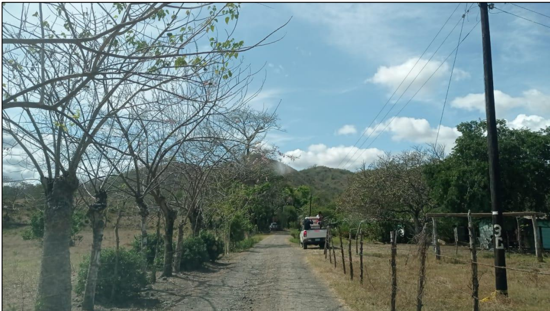
Fotografía N°6. Vista General Vía a Rehabilitar - Inicio Ramal Izquierdo Río Arriba.
