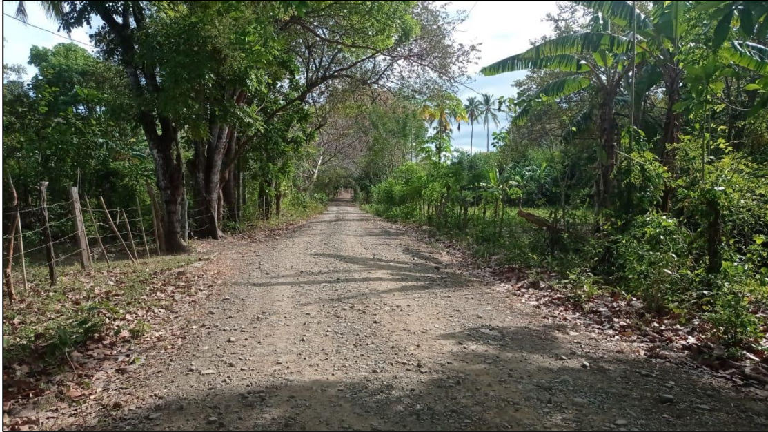
Fotografía N°19. Vista General de la vía a Rehabilitar. Calle Lateral a Escuela Agua Buena.
