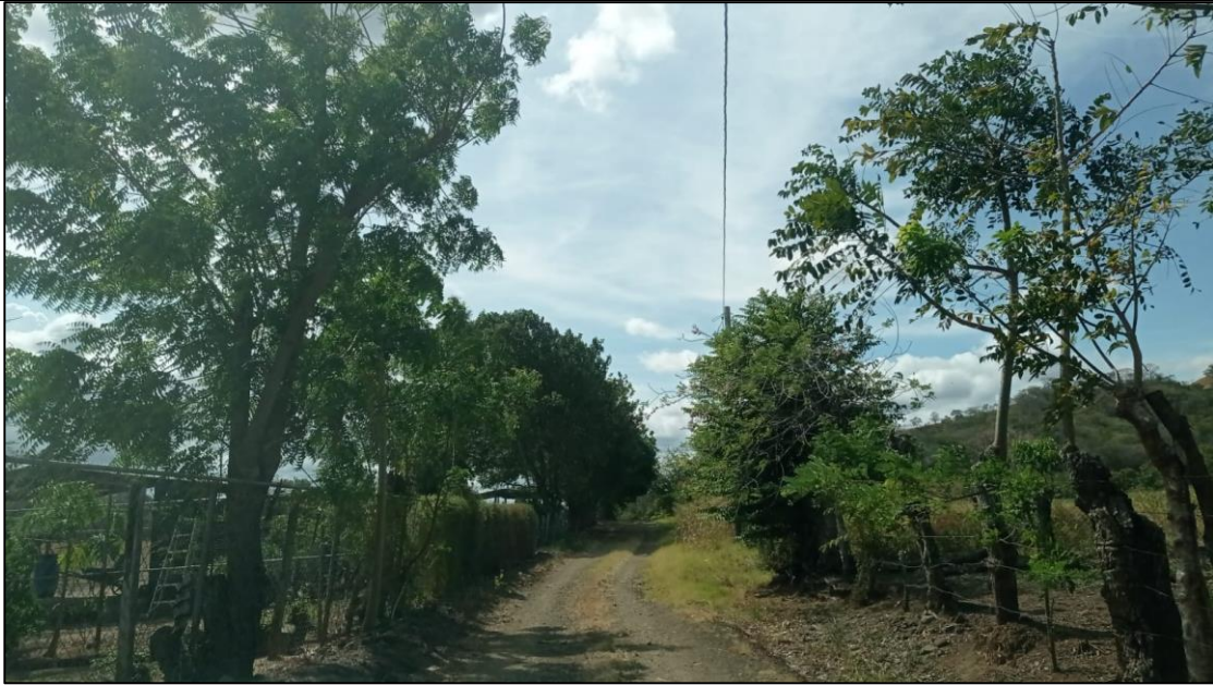
Fotografía N°11. Vista General de la vía a Rehabilitar. Ramal Ojo de Agua
