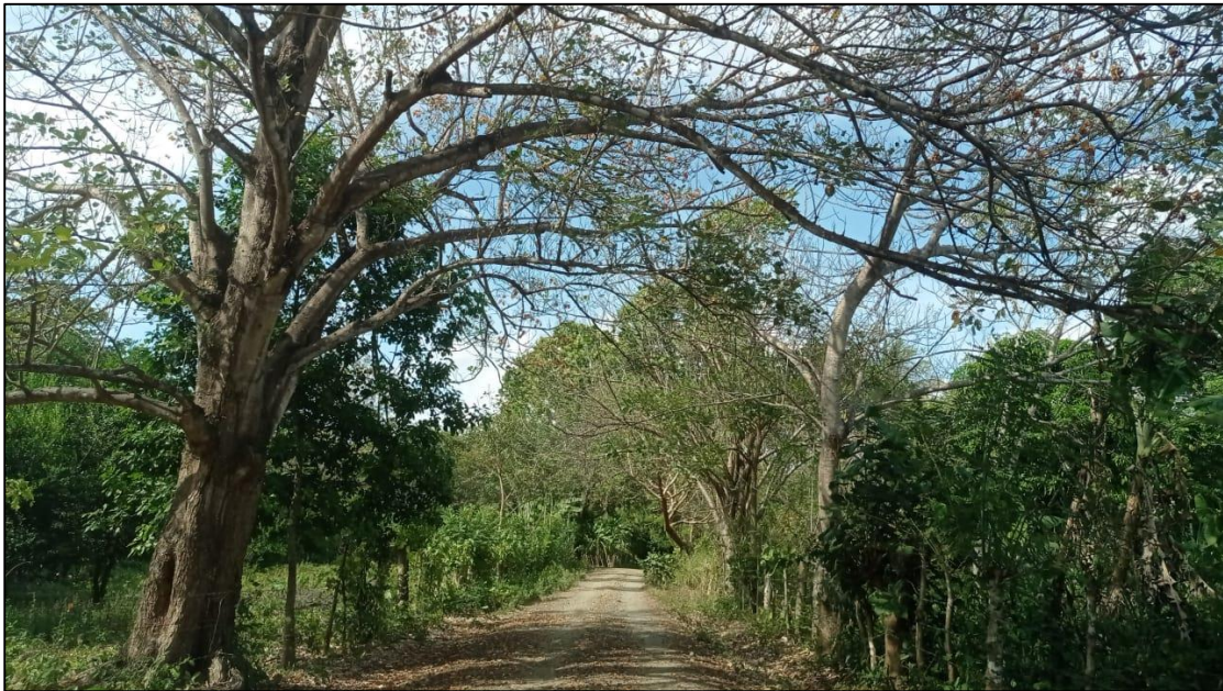
Fotografía N°16. Vista General de la vía a Rehabilitar. Calle Lateral a Escuela Agua Buena. Se realizará poda en esta área.
