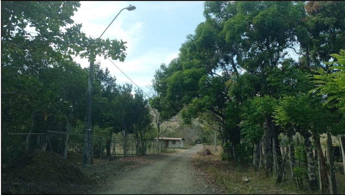
Fotografía N°7. Vista General de la vía a Rehabilitar - Ramal Izquierdo Río Arriba.
