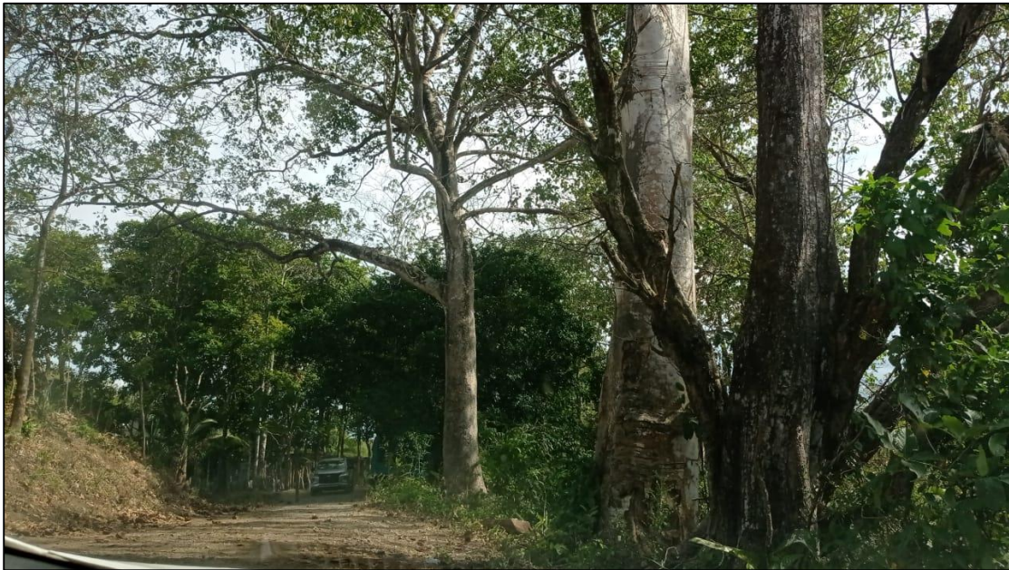
Fotografía N°20. Vista General de la vía a Rehabilitar. Final de Calle Lateral a Escuela Agua Buena.
