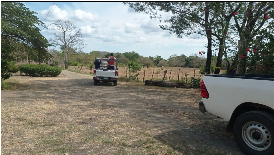
Fotografía N°8. Vista General de la vía a Rehabilitar. Final Ramal Izquierdo Río Arriba.
