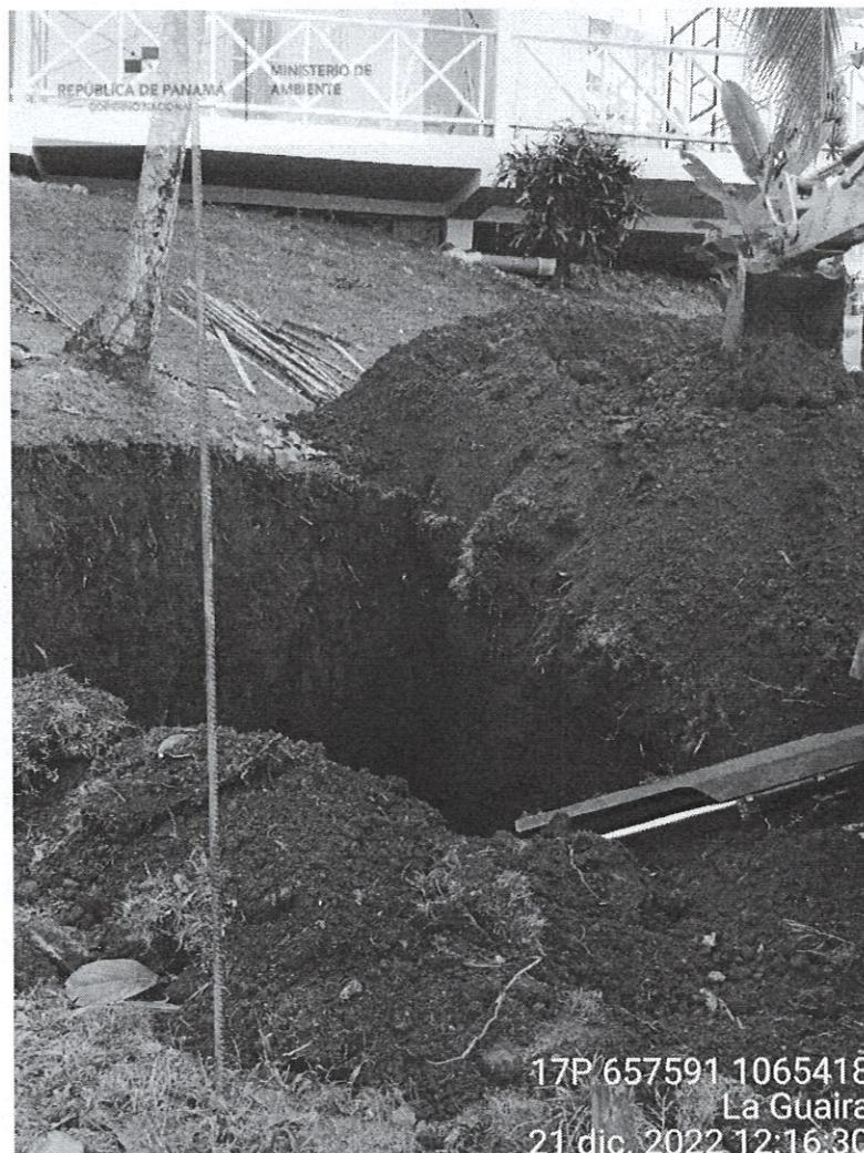
Foto. 10. Area de excavación para Inslación de biodigestores
