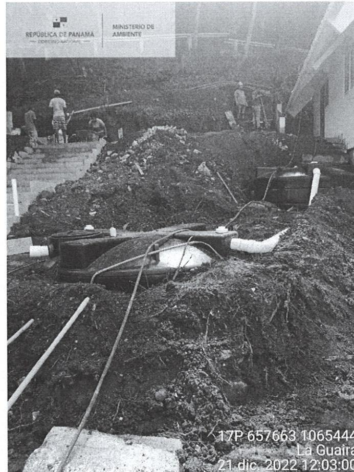
Foto. 9. Inslación de biodigestores
