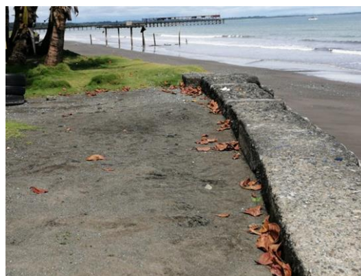
Foto 4. Muro de contención.
