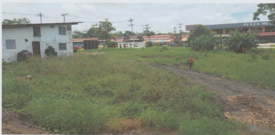
Foto N° 5: Vista panorámica del área del proyecto, a la izquierda hospedaje la Nachira que será demolido. Fuente: Julio Cruz / agosto / 2022.
