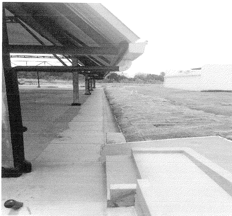
Imagen 3-5 – Media caña en la parte frontal y los dos laterales de la cancha multiusos
