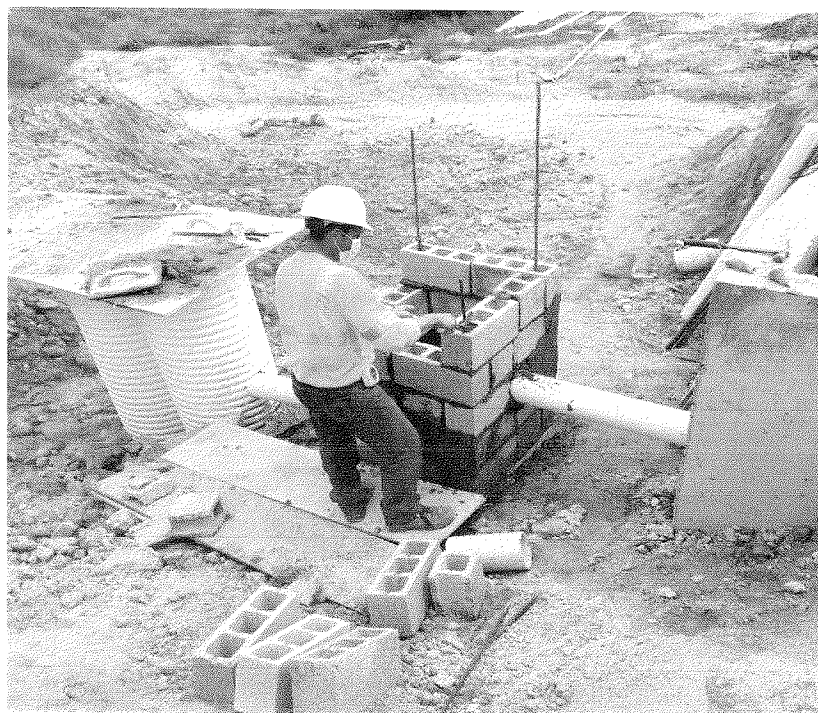
Figuras 1 y 2 – Posición de las tuberías del pozo de percolación en cama de arena y piedra y conexión desde la caja de muestreo
