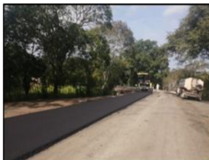
Imagen #11. Ejemplo de colocación de carpeta asfáltica.
