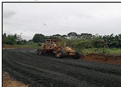
Imagen #9. Ejemplo de colocación de capa base.
