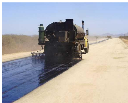
Imagen #10. Ejemplo de Riego de Imprimación.
