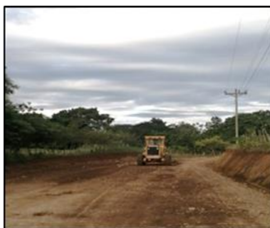
Imagen #8 Ejemplo De Colocación De Material Selecto.
