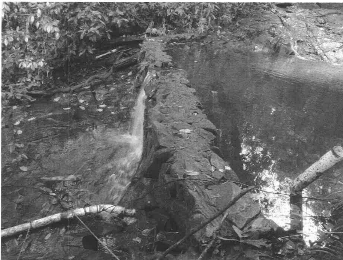
Imagen #13 Apariencia de la toma del acueducto rural del pueblo Coclé del Norte, sobre la quebrada Juan Francisco. Dicha toma fue construida en los años 1941.
