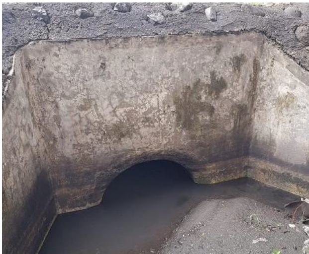
Foto No. 6.9-3 y Foto 6.9-4. Poca capacidad de transporte de la tubería que lleva las aguas al polígono, procedentes de la vía Corredor Norte y condiciones de la misma en el polígono.
