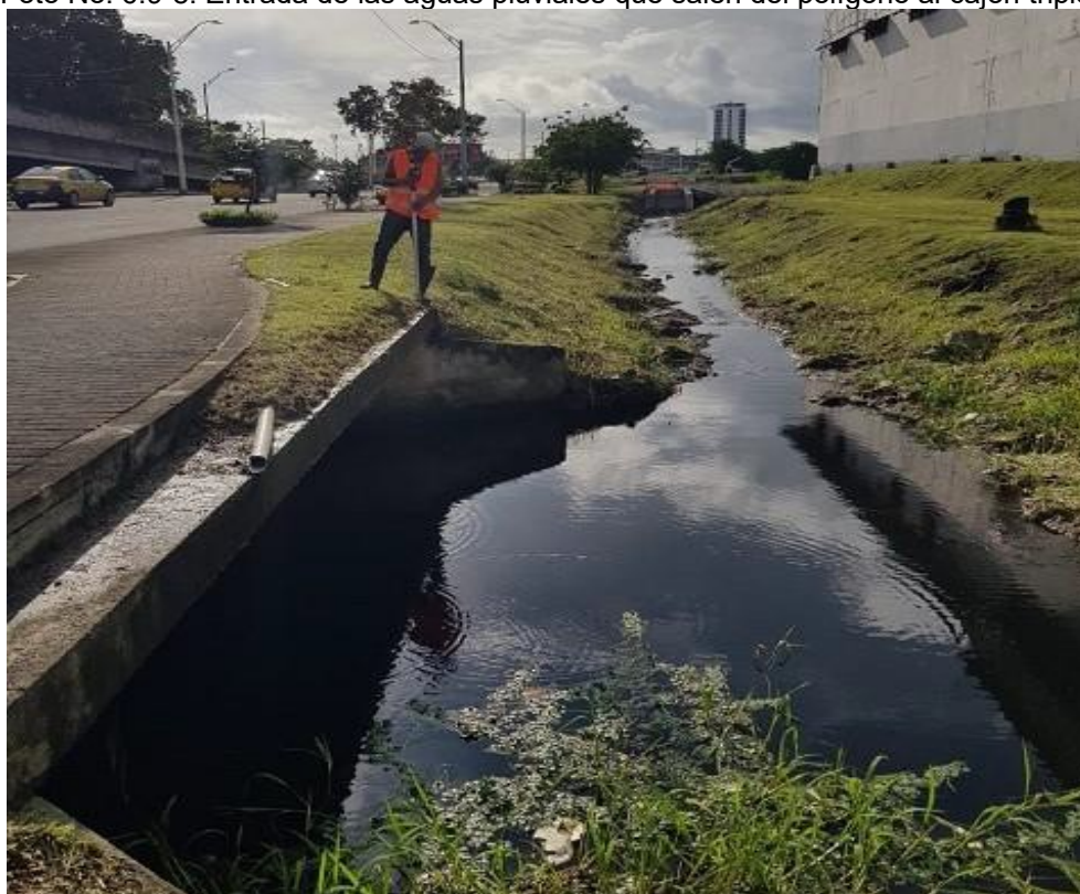
Foto No. 6.9-9. Salida de las aguas pluviales hacia la descarga final. Nótese que con un análisis adecuado, se puede mejorar la capacidad de conducción de las aguas hacia la Bahía.
