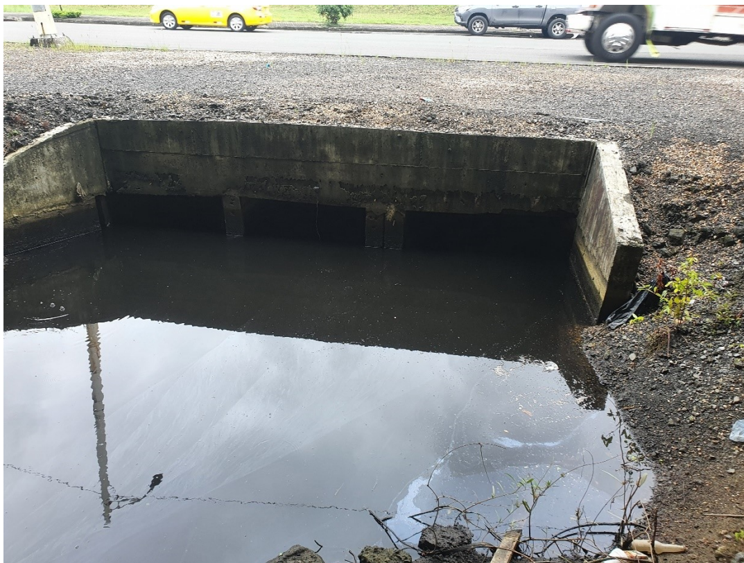
Foto No. 6.9-8. Entrada de las aguas pluviales que salen del polígono al cajón triple.
