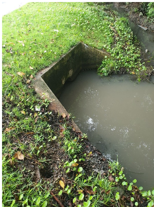
Foto No. 6.9-3 y Foto 6.9-4. Poca capacidad de transporte de la tubería que lleva las aguas al polígono, procedentes de la vía Corredor Norte y condiciones de la misma en el polígono.
