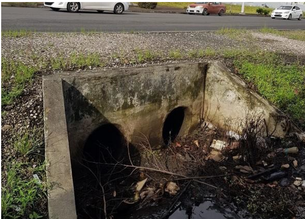
Foto No. 6.9-6. Vista de las dos líneas de hormigón de 0.60m de diámetro que salen del polígono.
