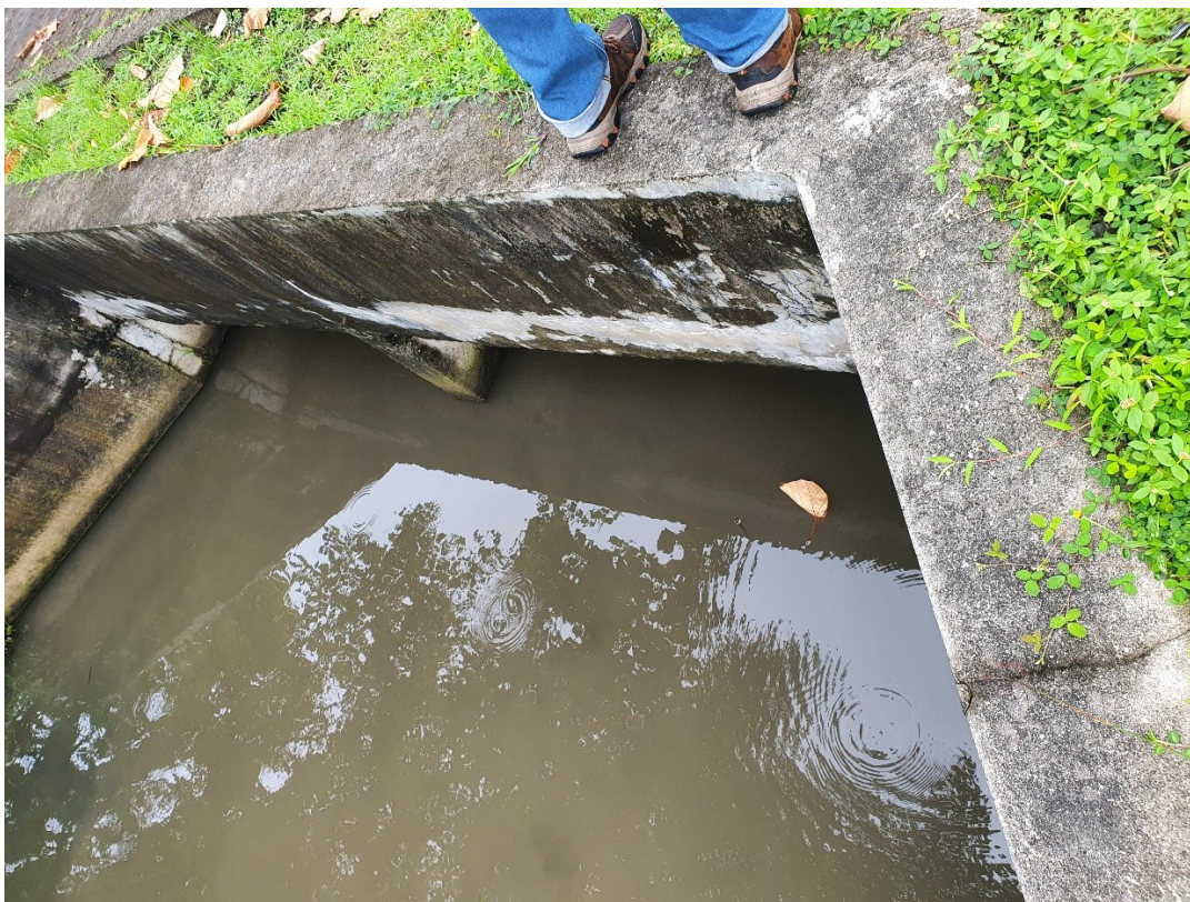
Foto No. 6.9-1. Entrada al cajón doble de las aguas provenientes de un canal abierto colindante con la comunidad de Arco Iris.
