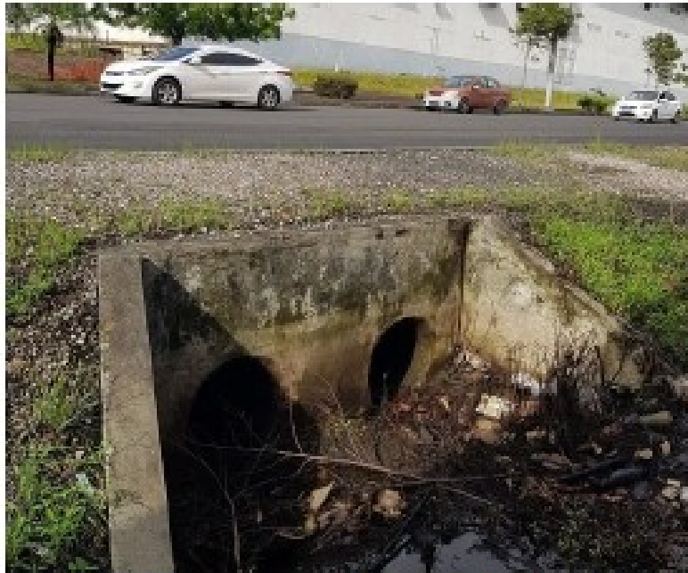
Foto No.4: Vista de las dos líneas de hormigón de 0.60m de diámetro que salen de la Parcela A101-03A hacia la Bahía de Manzanillo.
