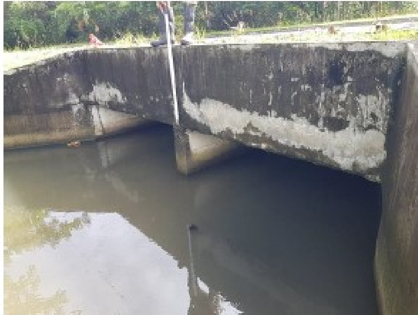
Foto No.1: Vista de la alcantarilla de cajón doble de 2.15m x 1.50m que llega a la Parcela A101-03A (sector de Arco Iris).
