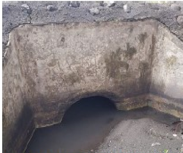
Foto No.2: Vista de la tubería de 0.60m de diámetro que drena hacia la Parcela A101-03A.
