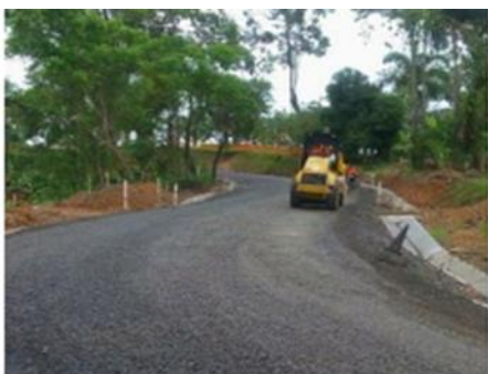
Figura #16. Colocación de Capa base
