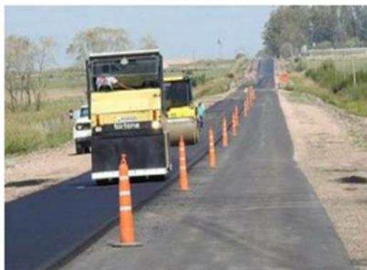
Figura #18 - Colocación de carpeta asfáltica
