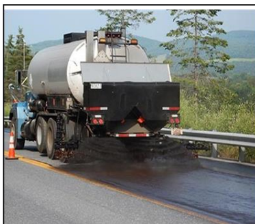
Figura #17 – Riego e Imprimación
