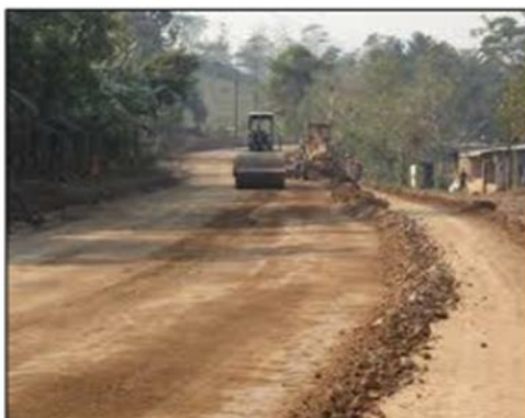
Figura #15. Colocación de Selecto
