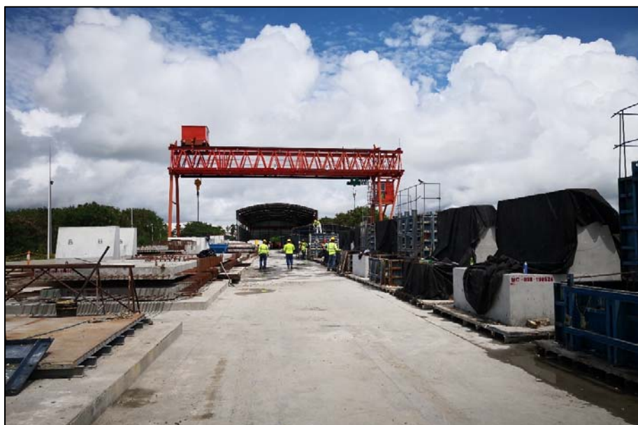
Ilustración 5-6. Patio de elementos prefabricados (b)
