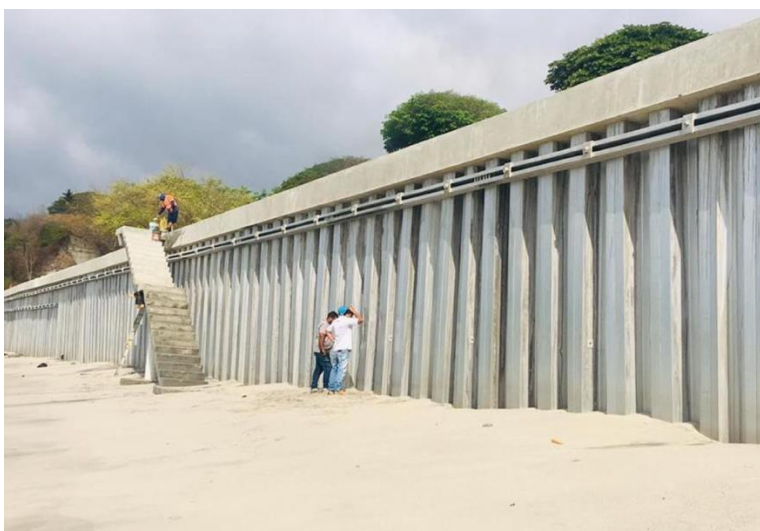
Ilustración 10. Tablestacado de Costa Esmeralda
