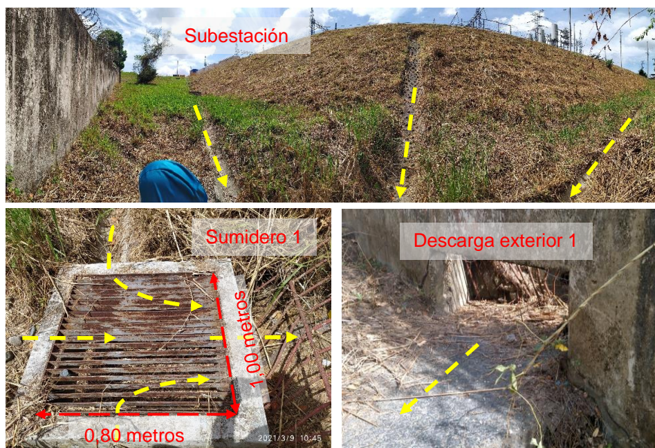
Figura 4-3. Reconocimiento de obras hidráulica en subestación Panamá – Descarga 1.
