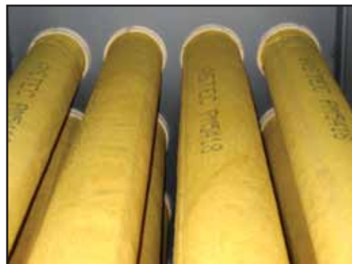
Las bolsas de filtrado y jaulas instaladas en fábrica ahorran tiempo y mano de obra.
