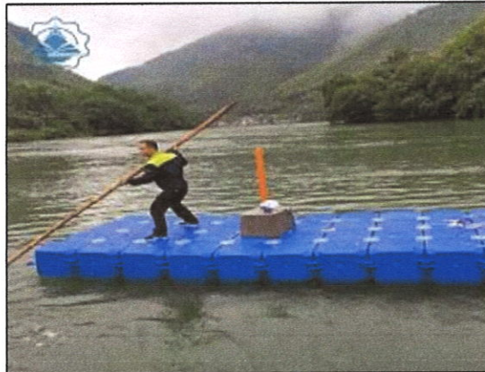
Imagen 6. Pontón como plataforma de trabajo para el área debajo de la plataforma del muelle 16.
