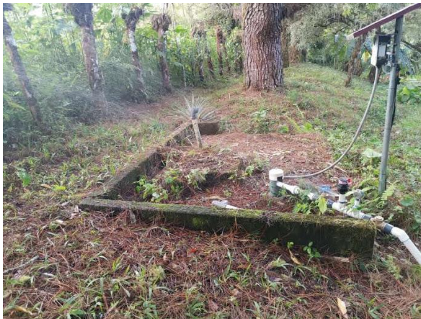
Imagen 10. Estructuras de captación de ojo de agua, existentes.
