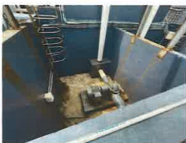
Foto 8. Vista de una de las bombas que succionan el agua de mar que ingresa al Laboratorio (octubre 2022).
