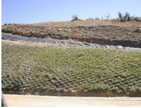
Uso de geoceldas y revegetación del talud.
