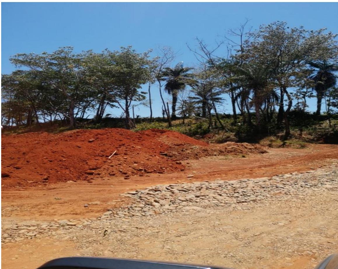
**Foto 1.** Suelo arcilloso en el sitio, necesario para la impermeabilización de las tinas
