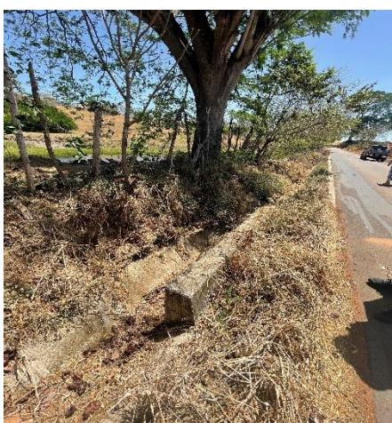
Entrada de las aguas pluviales, obsérvese el dique en la sección superior del talud.
