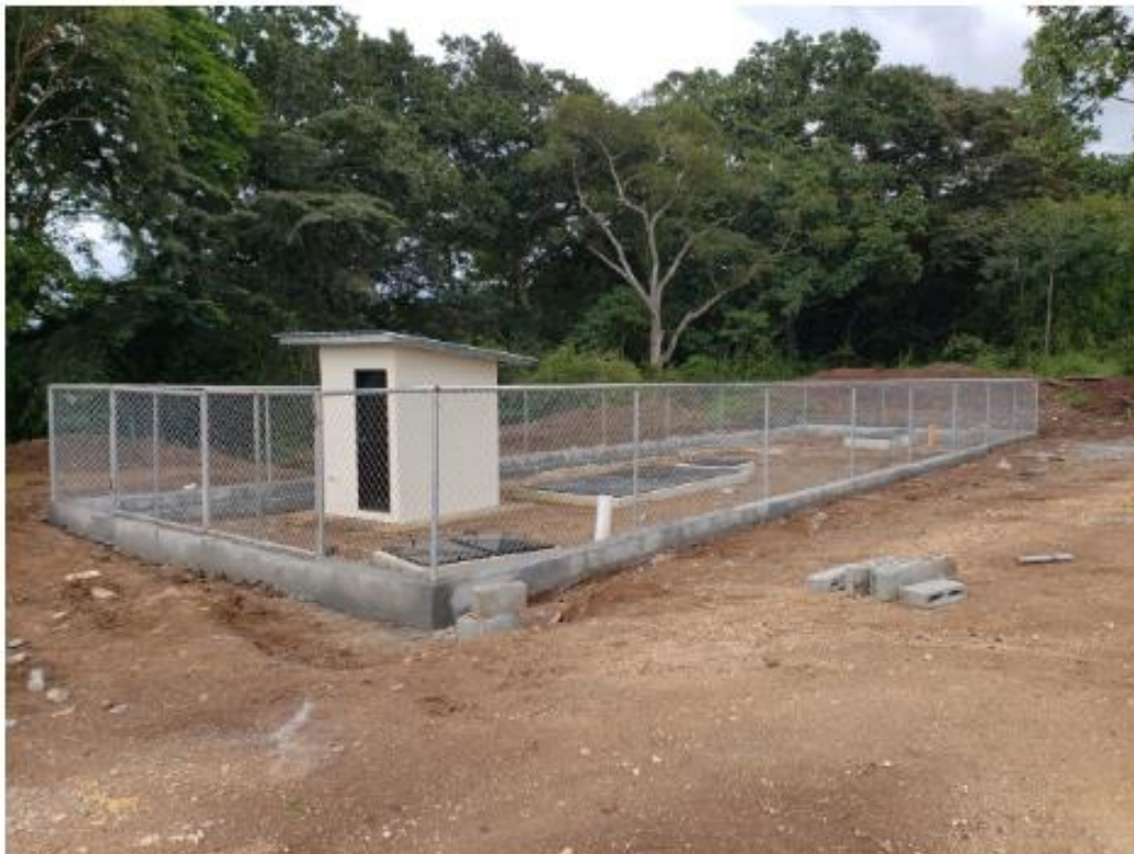
Ejemplo de instalacion de cuarto de baño y de la cerca perimetral con malla ciclon
