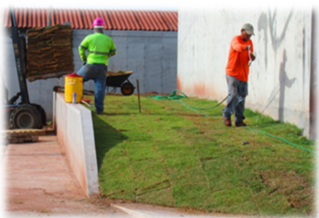
Fotografía 6 Colocación de grama sobre suelos desnudos
