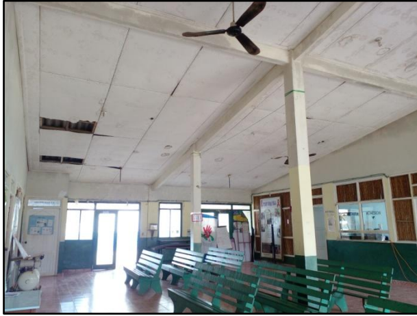
Foto 6. Sala de espera. Podemos observar la condición actual del cielo raso y la presencia de filtraciones.
