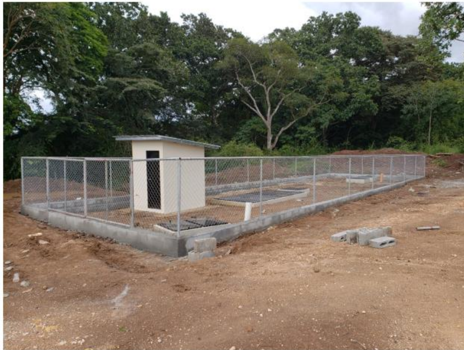
Ejemplo de instalacion de cuarto de baño y de la cerca perimetral con malla ciclón
