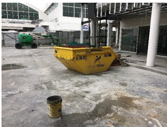
Figura 11. Tanquetas para almacenaje de desechos.
