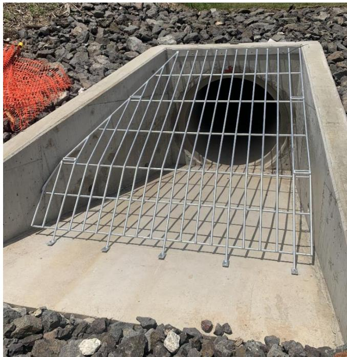
*Ilustración 26: Estructura de Protección de Cabezal.*
