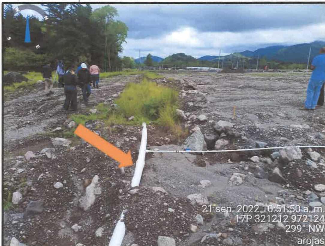
Figura 11 - Vista de la tubería de agua potable que atraviesa el polígono y deberá ser cambiada de lugar. proyecto ESTUDIO, DISEÑO, SUMINISTRO DE MATERIALES, MANO DE OBRA Y EQUIPO Y ADMINISTRACIÓN PARA LA CONSTRUCCIÓN DEL PROYECTO DE URBANIZACIÓN CON OBRAS DE INFRAESTRUCTURA DENOMINADO URBANIZACIÓN PASO ANCHO. septiembre 2022. Fuente: arojas
