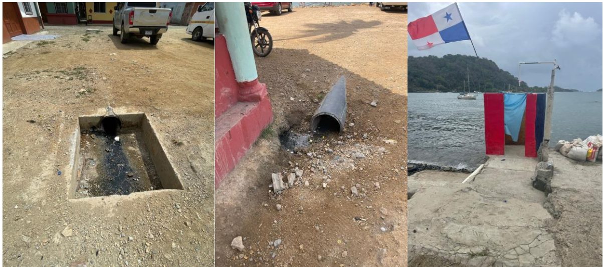
Figura 54. Sistema de descarga de aguas por fuentes residenciales
