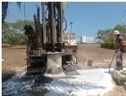
Figura 18. Perforación del Pozo 1-23.
