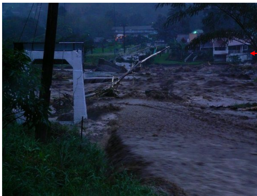
FIGURA 9. PUENTE PANAMONTE DESTRUIDO POR LAS AGUAS DE LA CRECIDA DEL RÍO CALDERA EN NOVIEMBRE DE 2008, VISTO DESDE LA ORILLA ESTE, IZQUIERDA VIENDO EN EL SENTIDO DE LA CORRIENTE, DEL RÍO. DE ACUERDO A UN RESIDENTE DEL RESIDENCIAL INDICADO, EL AGUA SUBIÓ 1 METRO POR ENCIMA DEL SUELO EN ESTE SITIO..
