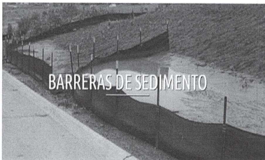
Figura 2. Barreras de control de sedimentos, a instalar en fase de construcción.
