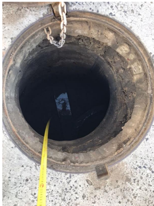
Figura N°17 Cámara de inspección
