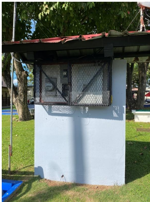
Figura N°19 Acometida eléctrica
