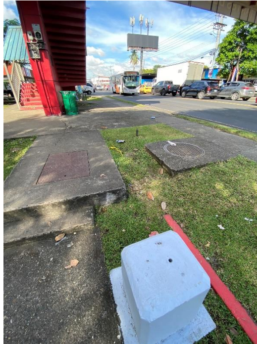
Figura N°16 Caja Eléctrica y cámara de inspección
