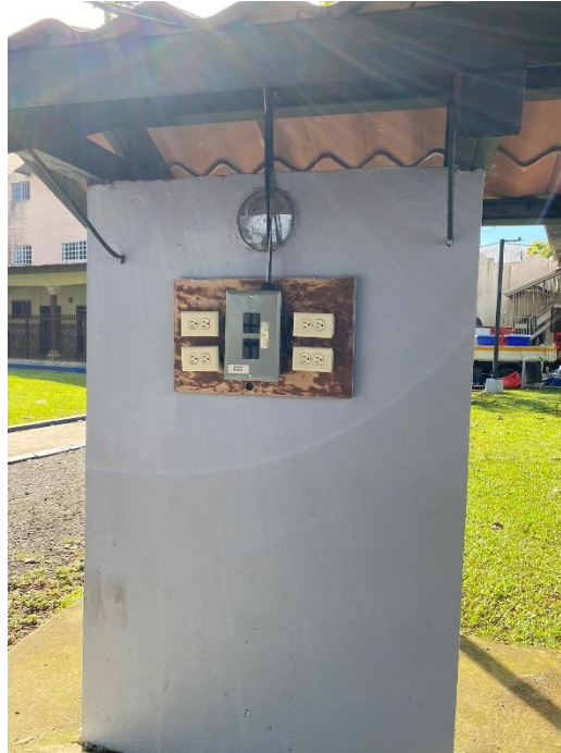
Figura N°18 Acometida eléctrica
