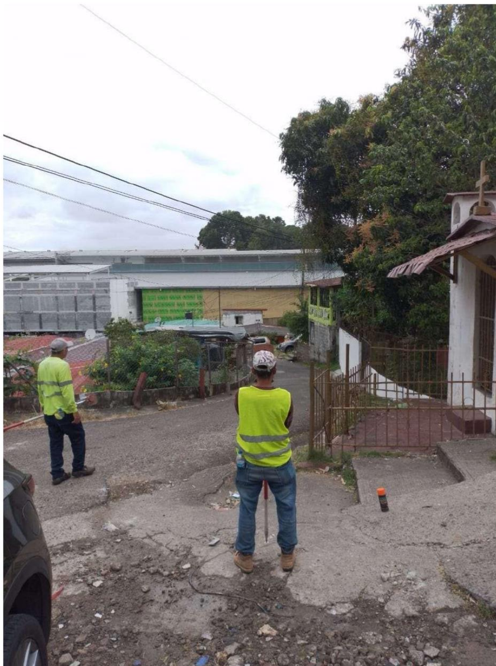
Vista de cadeneros realizando levantamiento de calles de asfalto y detalles en el sector de Santa Elena N°1
