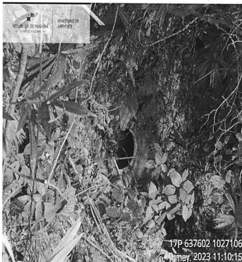
Foto 7. Alcantarilla existen que recoge las aguas del ojo de agua #1 y 2
