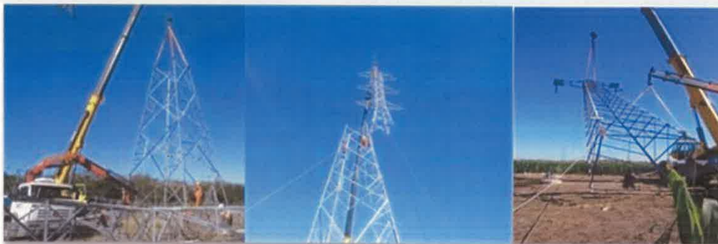
Pre-armado de torres en el suelo: Apoyo completo y por tramo.
