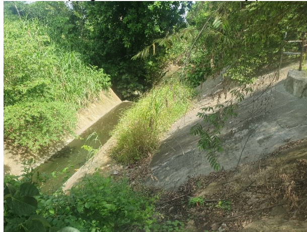
Fotos No. 6.6-3 y 6.6-4. Salida de la Quebrada Sin Nombre hacia el río Juan Díaz. Cajón pluvial pavimentado. Nótese la falta de mantenimiento, lo que no hace eficiente el flujo del agua.
