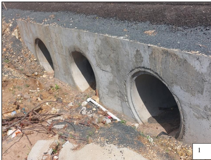
FOTOGRAFÍA 1-2: ESTACIÓN 5K+500 - TUBERIA TRIPLE DE 0.90 M Ø
