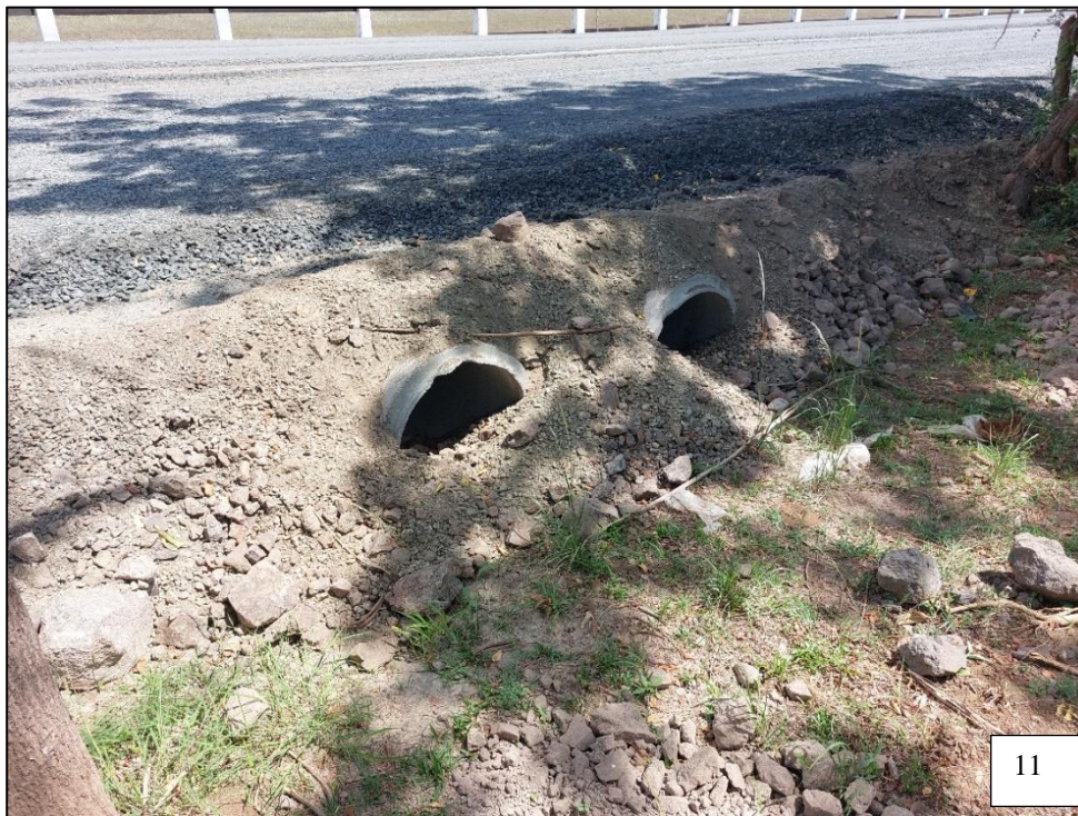
FOTOGRAFÍA 11-12: ESTACION 7K+987.50 – TUBERIA DOBLE DE 0.60 M Ø
