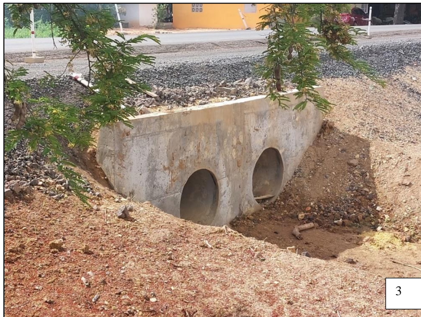
FOTOGRAFÍA 3-4: ESTACIÓN 6K+370 – TUBERÍA DOBLE DE 0.90 M Ø
