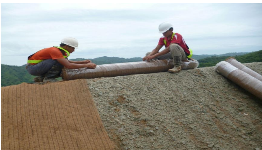
Figura 2-8: Instalación de mantas para control de erosión en taludes del Proyecto
