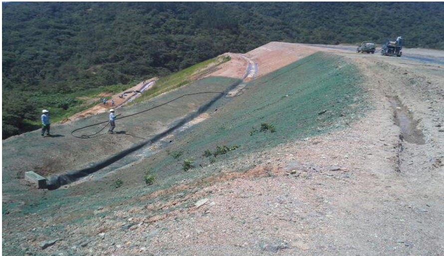
Figura 2-9: Trabajos de control de erosión en taludes del Proyecto
