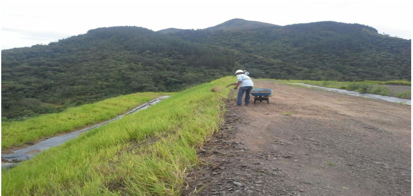
Figura 2-11: Labores de mantenimiento de áreas revegetadas en el Proyecto
