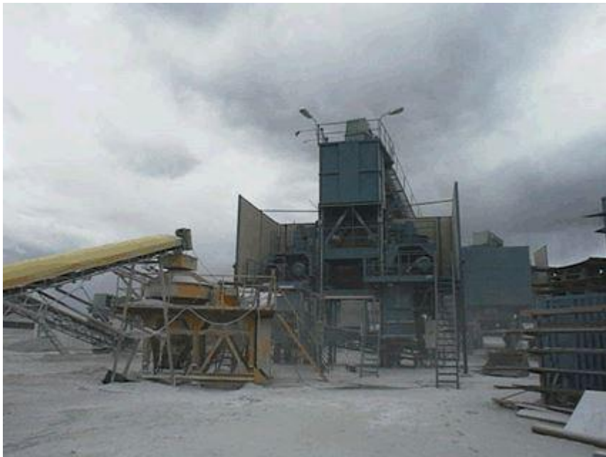
Figura 2-12: Medida de contención de ruido, barreras acústicas.
