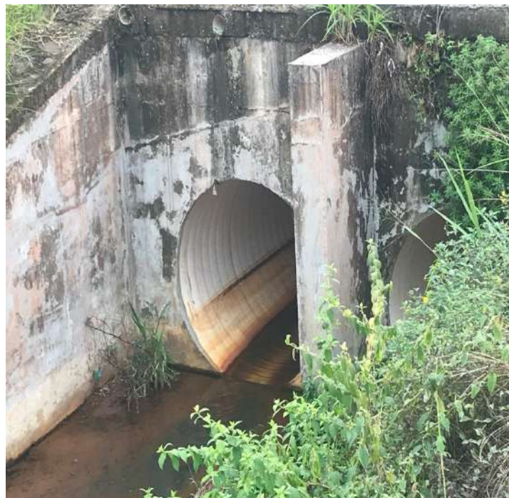
Quebrada s/n, donde descarga la tubería pluvial soterrada existente. Esta es la misma quebrada propuesta en el Estudio de Impacto Ambiental para la descarga de las aguas residuales totalmente limpias y tratadas, cumpliendo con las Normativas Ambientales, específicamente COPANIT - 035-2000
