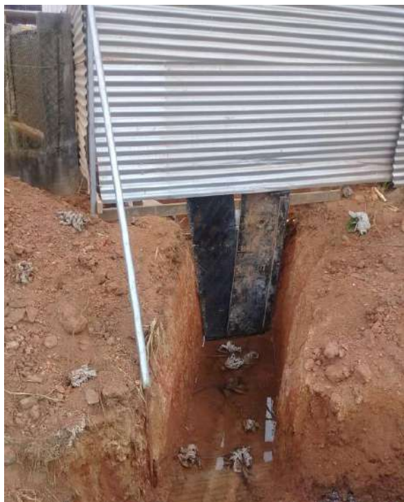
Límite del terreno de la escuela y salida de tubería de 6 pulgadas que irá soterrada a conectarse con la tubería pluvial existente, que también se encuentra soterrada
