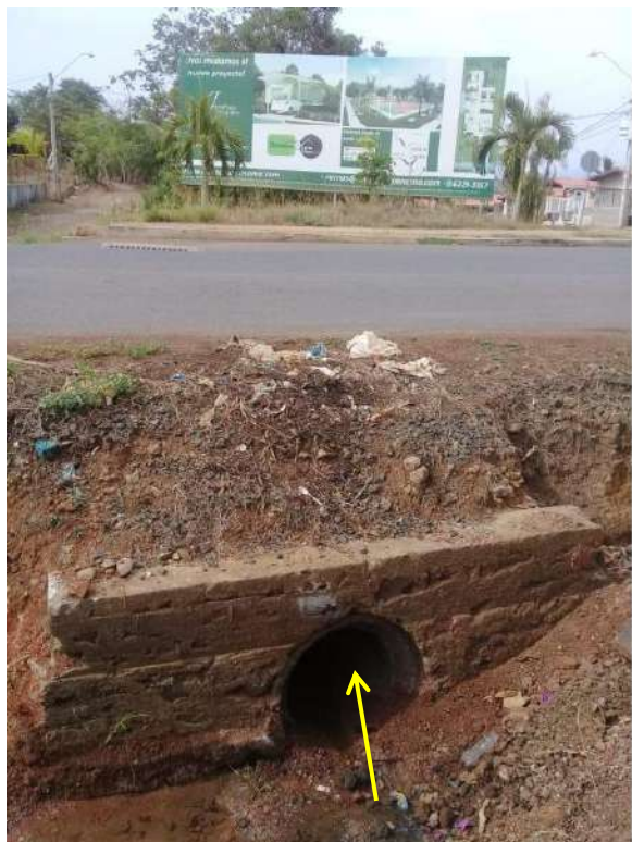
Se observa tubería pluvial que cruza la Calle El Limite, totalmente soterrada hasta su descarga a la quebrada s/n. Este es el punto donde la empresa propone hacer la conexión soterrada de la tubería de 6 pulgadas procedente de la planta de tratamiento y entregar al cajón pluvial las aguas tratadas y limpia.
