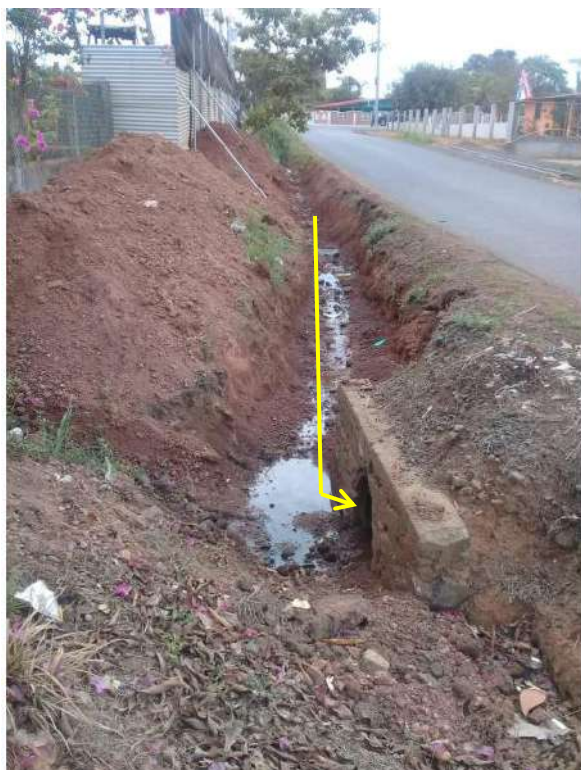
Se observa tubería pluvial que cruza la Calle El Limite, totalmente soterrada hasta su descarga a la quebrada s/n. Este es el punto donde la empresa propone hacer la conexión soterrada de la tubería de 6 pulgadas procedente de la planta de tratamiento y entregar al cajón pluvial las aguas tratadas y limpia.
