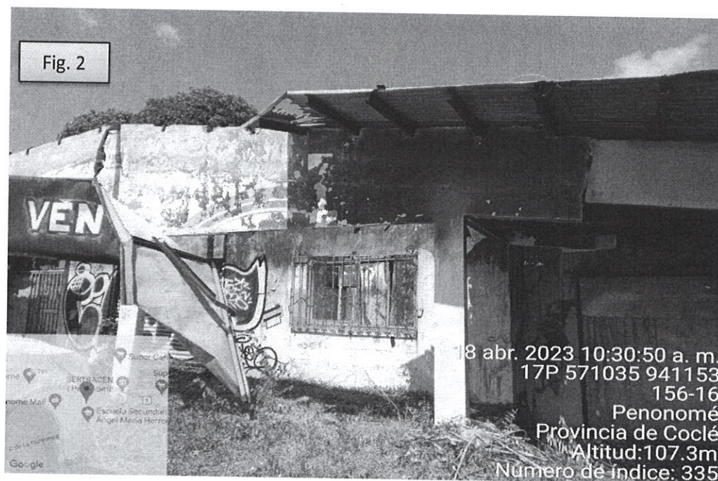
Fig. 2: Se puede observar las paredes del local existente en el área del proyecto; el mismo se encuentra quemado y en algunas partes no cuenta con el techo.
