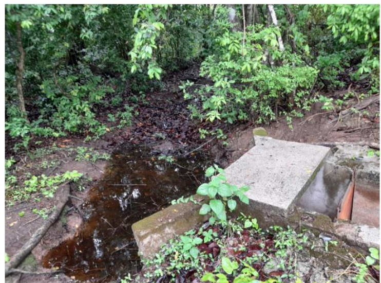
Estructura de derivación a canal secundario
