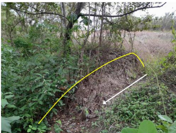
Muro del drenaje abierto para evacuar el agua del campo.
