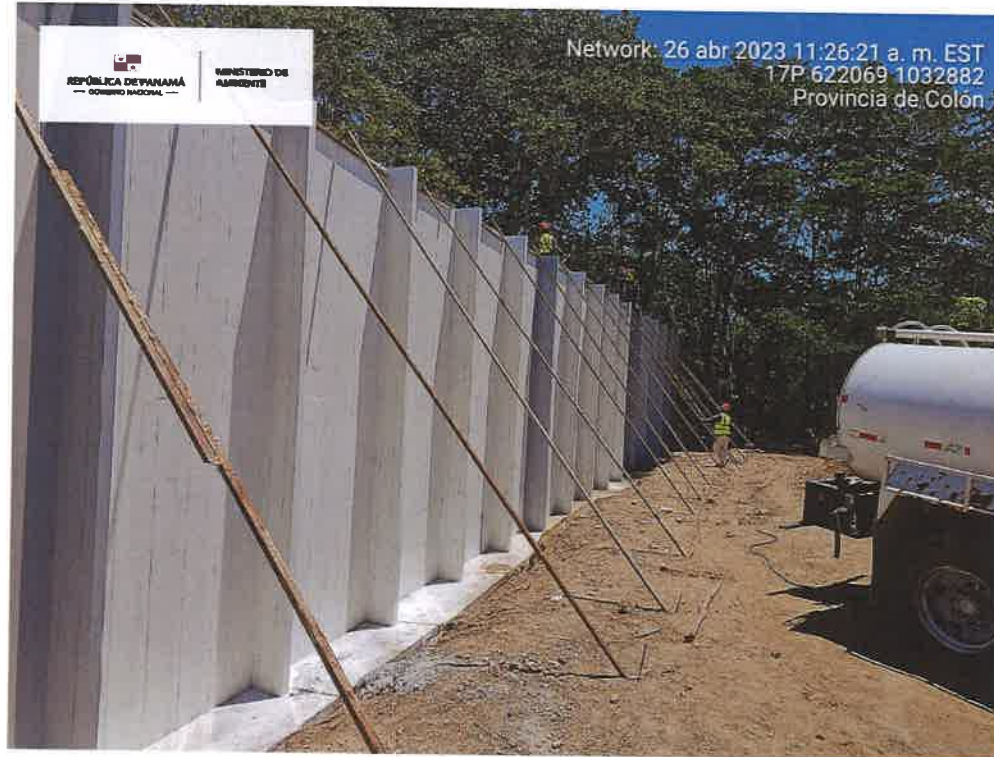
Figura 8. Trabajos de construcción ( levantamiento de muro con pvc relleno ), muy cercanos a la zona costero marina del sector de Atlantic Plaza-4 Altos.
