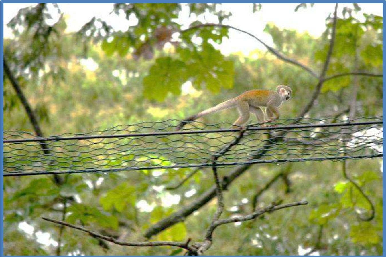
Tipo de Pasos aéreo de Fauna, a utilizar en el proyecto *“Estudio, Diseño, Construcción, y Mantenimiento de Obras para la Ampliación y Rehabilitación de la Carretera Panamericana, Tramo: Puente De Las Américas – Vía Centenario en Arraiján”*, el mismo tendrá una longitud total de 103.31 m x 1.0 m de ancho, con este cruce se busca salvaguardar la vida de animales silvestre.
