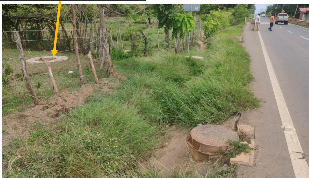
Imagen N°6. Cámara Inspección donde llegaría la línea de impulsión
