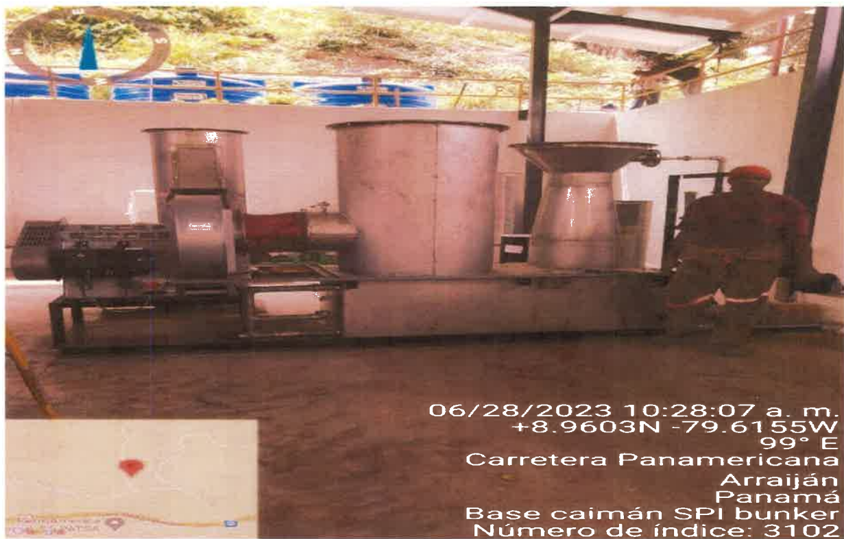
Segunda cámara de quemado de gases y filtro de lavado y precipitación
