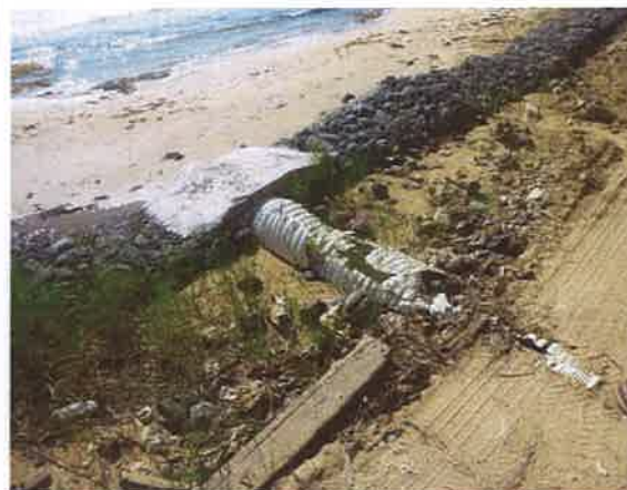
Foto 4. Tubería de drenaje con rupturas por el paso vehicular.
