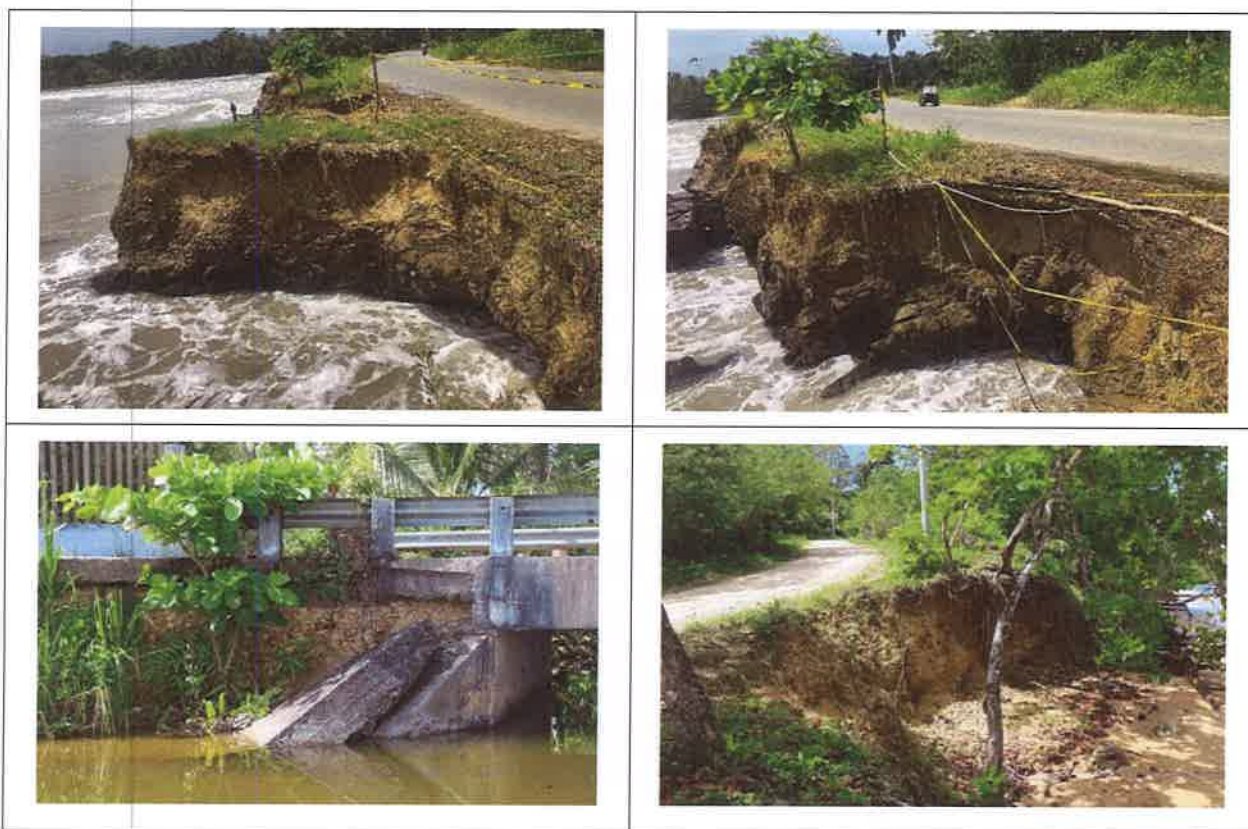
Ilustración 1. Área de erosión en la Fase B del proyecto.
