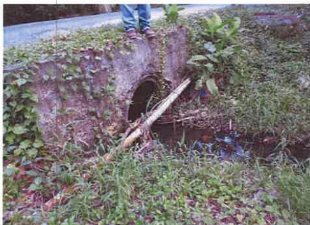
Foto 3. Material obstruyendo el cajón pluvial.
