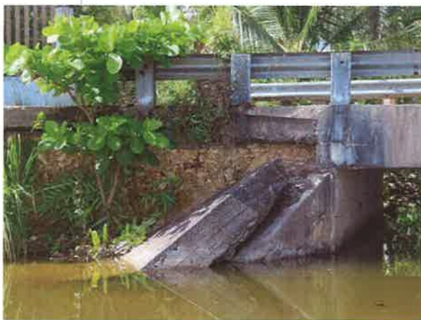
Foto 1. Parte de estructura de puente colapsada
