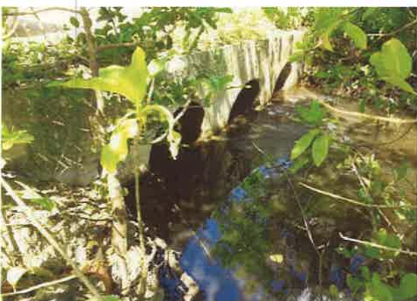
Foto 3. Material obstruyendo el cajón pluvial.
