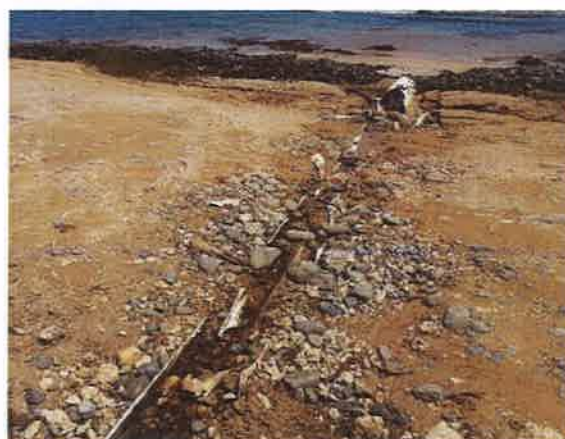
Foto 4. Tubería de drenaje con rupturas por el paso vehicular.
