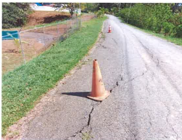
Foto # 11: Tramo propenso a colapso por fisuras considerables.
