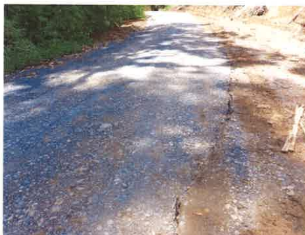
Foto # 15: Vistas de grietas a borde de vía, existentes, selladas a la fecha con material pétreo pero existentes.
