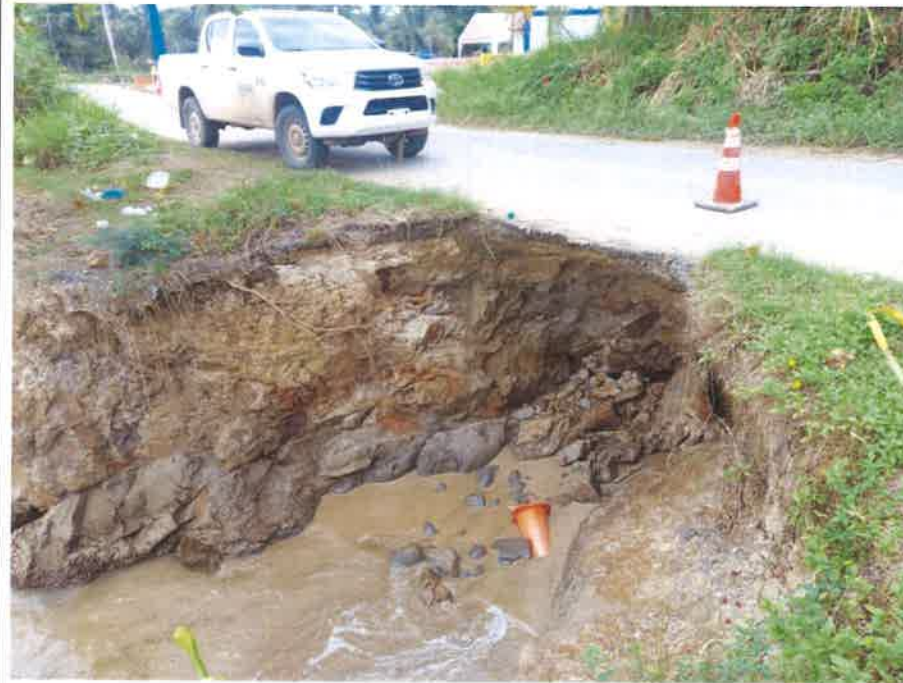
Foto #3: Afectación a la vía directa, tramo en riesgo de colapso total.
