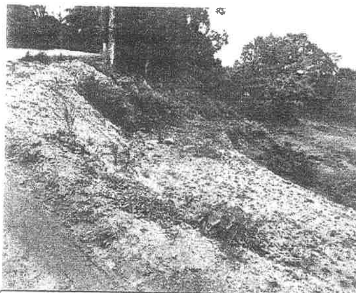
Foto 6. Laderas existentes con falta de recubrimiento de su superficie.
