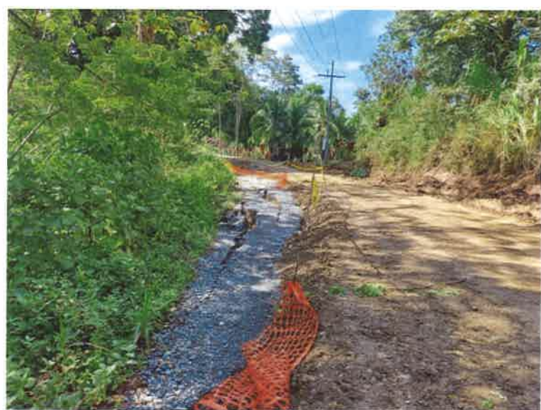
Foto # 9: Vistas de grietas a borde de vía, existentes, selladas a la fecha con material pétreo pero existentes.
