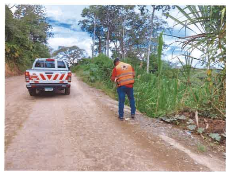
Foto #10: Evaluación actual, se tiene tramo de 170 m con desprendimiento a borde de camino.
